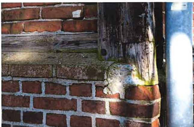
Fot. nr 29 Narożnik północno – wschodni - sposób oparcia drewnianego słupa narożnego na wykonanej wysokiej ścianie fundamentowej
