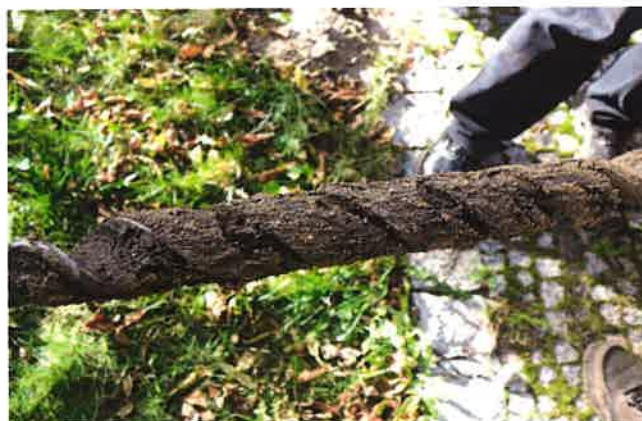
Fot. nr 128 Ściana południowa - odwiert geologiczny- duża plastyczność zalegającego gruntu
