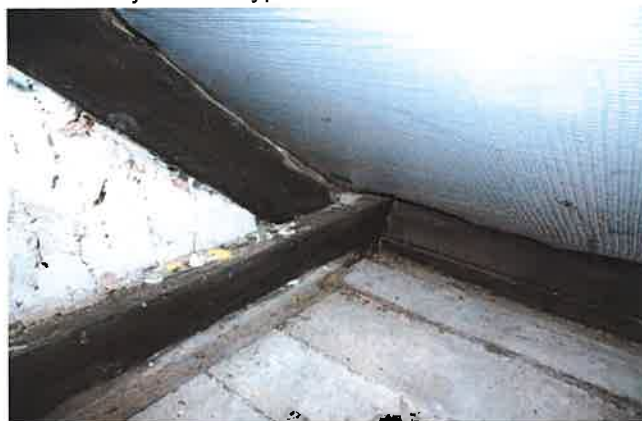
Fot. nr 108 Konstrukcja więźby dachowej-membrana dachowa ułożona w 2005 roku podczas prac remontowych
