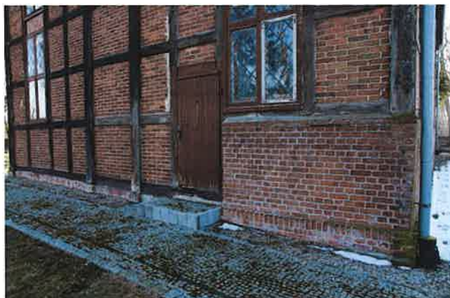
Fot. nr 37 Północno-wschodni narożnik – wysoka ściana fundamentowa
