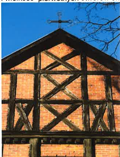
Fot. nr 141 Ściana południowa, szczytowa – pierwotna forma konstrukcji ryglowej
