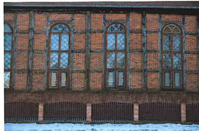
Fot. nr 132 Ściana północna – pierwotna forma i układ otworów okiennych
