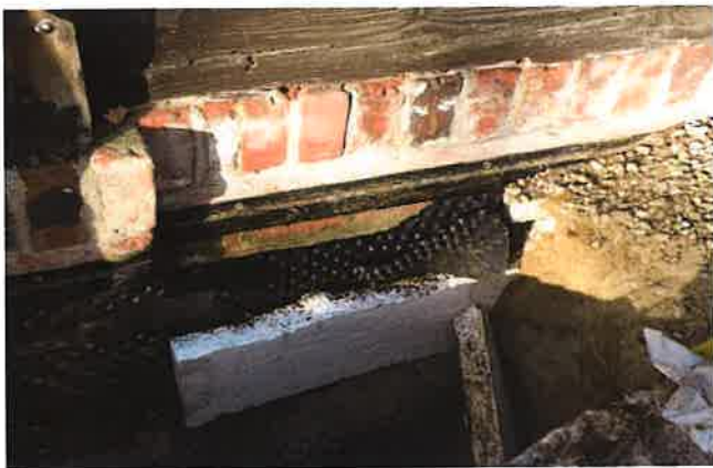
Fot. nr 121 Ściana południowa - wykop badawczy zewnętrzny – widoczna folia kubełkowa oraz izolacja termiczna
