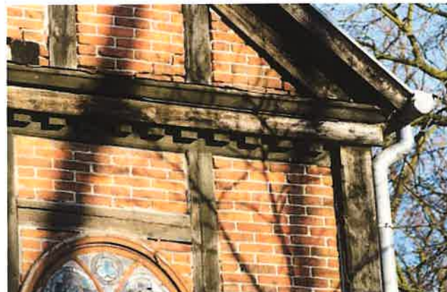
Fot. nr 54 Ściana zachodnia – widok gzymsu okalającego oraz elementów ryglowej konstrukcji szczytu
