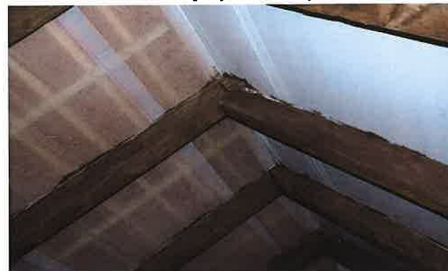
Fot. nr 112 Węzeł kalenicowy konstrukcji więźby dachowej
