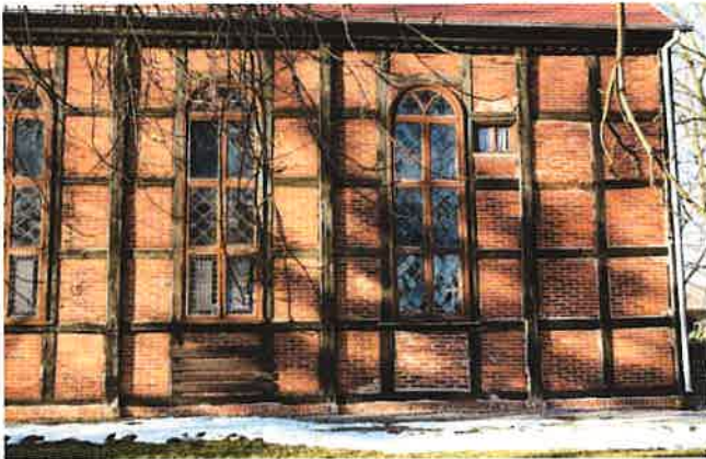
Fot. nr 133 Ściana południowa – pierwotna forma konstrukcji ryglowej - widoczne wprowadzone dodatkowe okno
