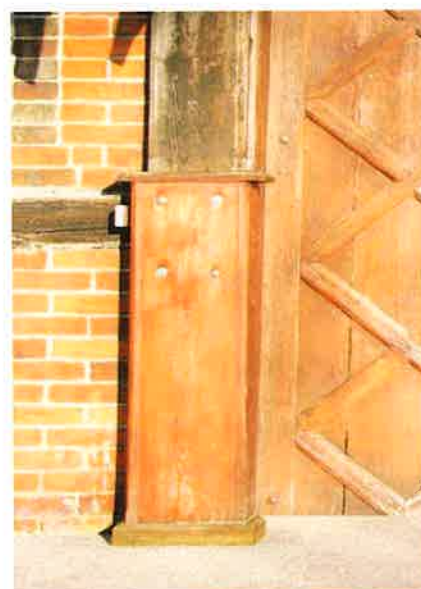
Fot. nr 144 Ściana zachodnia-obudowa dolnego poziomu słupa konstrukcji ryglowej deskami
