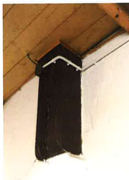
Fot. nr 148 Ściana wewnętrzna - element podpierający (konsola)
