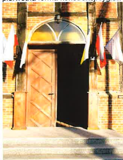
Fot. nr 143 Ściana zachodnia-widoczna przebudowana rama portalowa (wejściowa) w części cokołowej)
