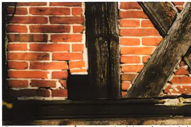
Fot. nr 76 Ściana zachodnia – konstrukcja ryglowa ściany szczytowej; widoczna belka nośna konstrukcji wsporczej wieży (belka prostopadła do linii gzymsu)
