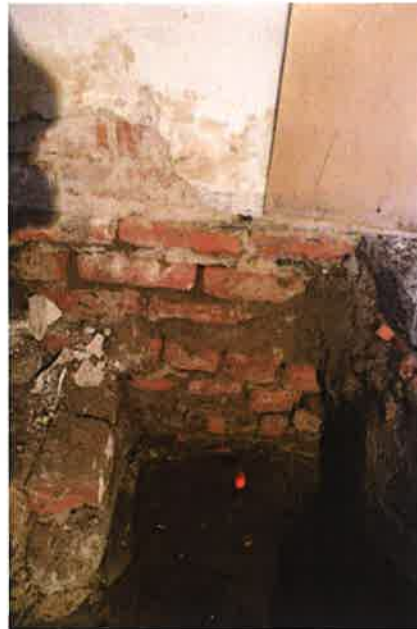
Fot. nr 158 Ściana południowa - wykop badawczy wewnętrzny - widok na posadowienie ściany wewnętrznej
