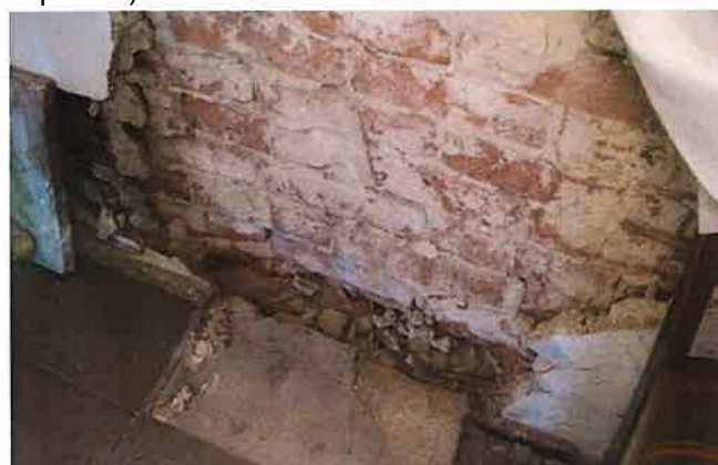
Fot. nr 155 Wykop badawczy w części wewnętrznej kościoła (zakrystia) - ściana południowa
