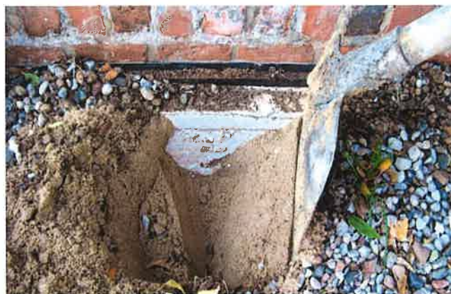
Fot. nr 119 Ściana południowa - odkrywka fundamentów; widoczna folia kubelkowa oraz izolacja termiczna- styropian o gr. 5 cm wykonane w 2009 roku
