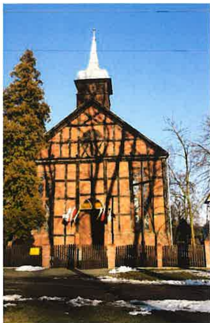
Fot. nr 7 Elewacja frontowa - ściana zachodnia – przymurowana ściana fundamentowa w obrębie obu narożników; w części centralnej konstrukcja pierwotna
