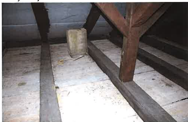
Fot. nr 107 Konstrukcja więźby dachowej-słup ramy stolcowej
