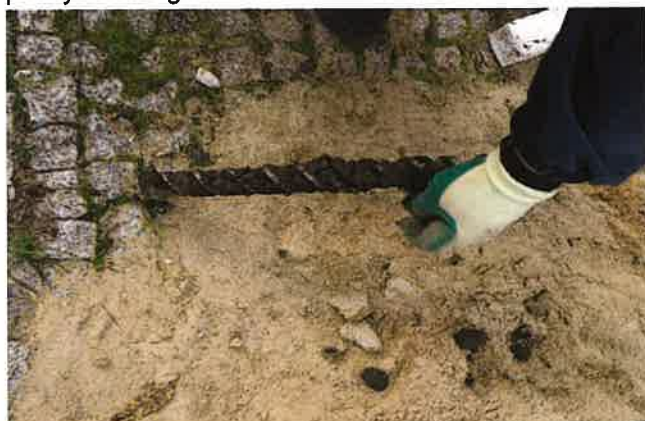
Fot. nr 129 Ściana południowa - odwiert geologiczny
