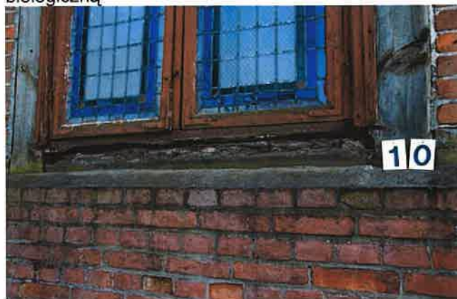
Fot. nr 137 Ściana północna – element podokienny oraz ościeżnica okienna
