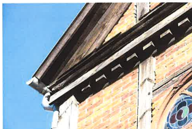
Fot. nr 52 Ściana zachodnia – gzyms ozdobny oraz fragment oryginalnej stolarki okiennej
