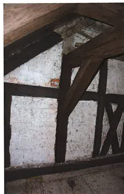
Fot. nr 104 Konstrukcja więźby dachowej oraz konstrukcja ryglowa ściany szczytowej wschodniej
