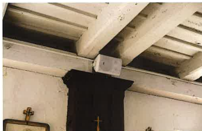
Fot. nr 101 Konstrukcja stropu belkowego empory; oparcie belek stropowych na podciagu
