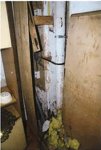
Fot. nr 159 Ściana południowa sposób prowadzenia instalacji wodociągowej i kanalizacyjnej
