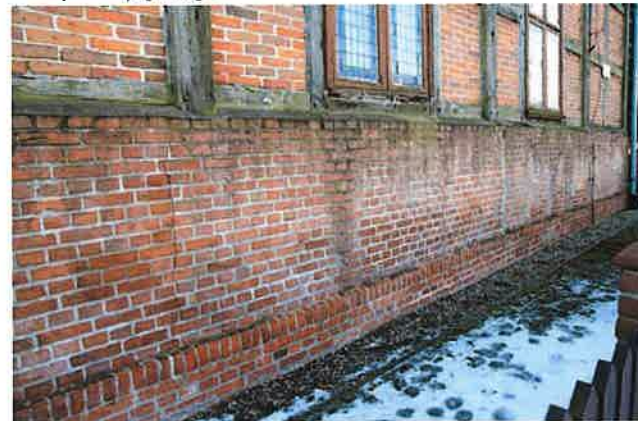
Fot. nr 46 Ściana północna – widoczna wysoka ściana fundamentowa, na której występują pęknięcia muru oraz próby „zszycia” pęknięć
