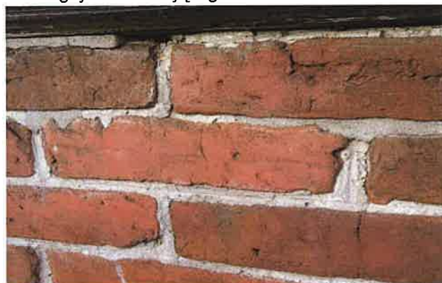
Fot. nr 62 Ściana południowa-ceglane wypełnienia konstrukcji ryglowej- spoinowanie
