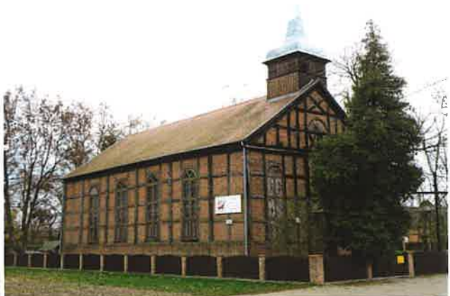
Fot. nr 4 Widok kościoła w 2013 roku – elewacja północna i zachodnia – stan obecny
