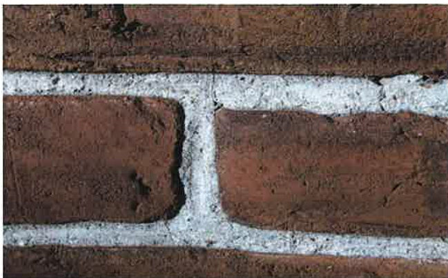
Fot. nr 63 Ściana południowa-ceglane wypełnienia konstrukcji ryglowej -spoinowanie
