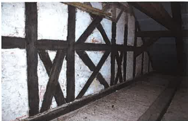
Fot. nr 105 Konstrukcja ryglowa ściany wschodniej szczytowej
