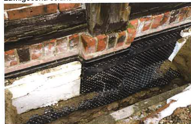
Fot. nr 126 Ściana południowa- odkrywka fundamentów; widoczna folia kubełkowa oraz izolacja termiczna - styropian o gr. 5 cm ułożona w przestrzeniach międzysłupowych
