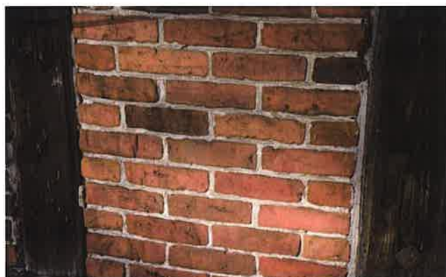
Fot. nr 61 Ściana południowa-ceglane wypełnienia konstrukcji ryglowej
