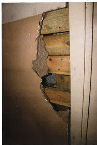
Fot. nr 152 Ściana wewnętrzna poziomu I piętra - sposób wykończenia poprzez wprowadzenie dodatkowego rusztu drewnianego do którego zostały przymocowane płyty pilśniowe
