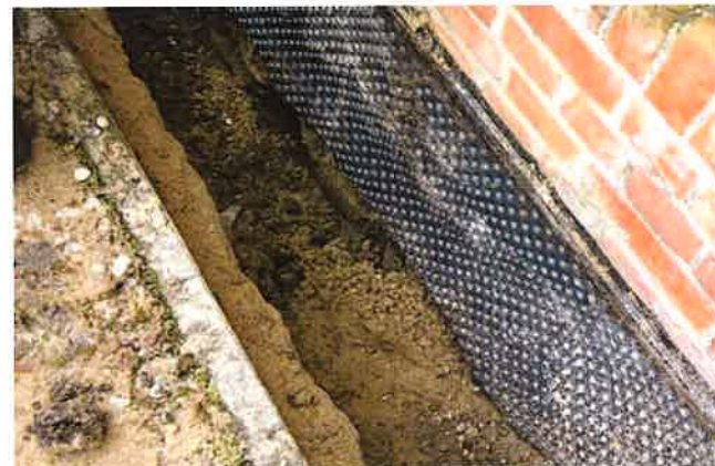
Fot. nr 120 Ściana południowa - wykop badawczy zewnętrzny – widoczna folia kubelkowa wraz z listwą mocującą
