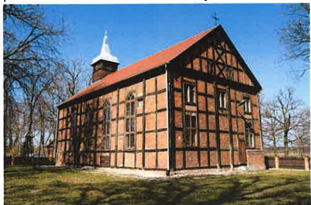
Fot. nr 6 Widok kościoła w 2013 roku – elewacja południowa i wschodnia – stan obecny
