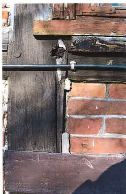
Fot. nr 33 Ściana południowa - elementy konstrukcji ryglowej
