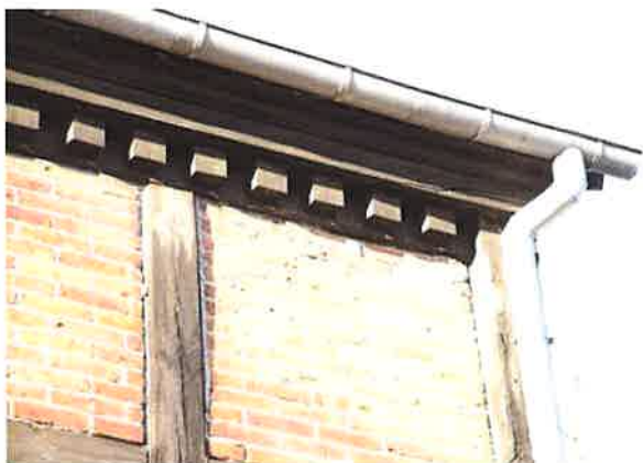
Fot. nr 57 Widok (prawdopodobnie oryginalnego) gzymsu obwodowego z elementami wykończenia w postaci klocków drewnianych nabitych na rygle poziome podokapowe – ściana południowa
