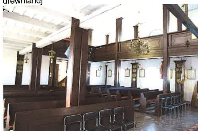
Fot. nr 90 Wnętrze kościoła - widok na empore oraz układ belek stropowych
