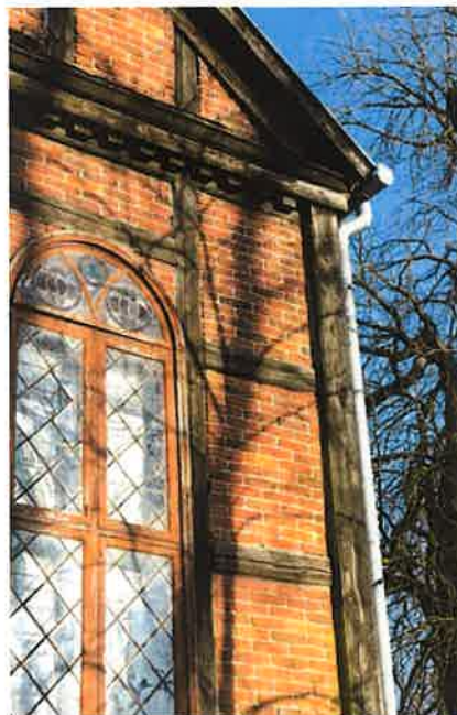
Fot. nr 10 Elewacja frontowa- ściana zachodnia – konstrukcja ryglowa
