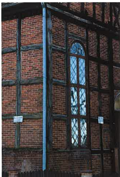
Fot. nr 51 Narożnik północno –zachodni z widoczną wysoką ścianą fundamentową
