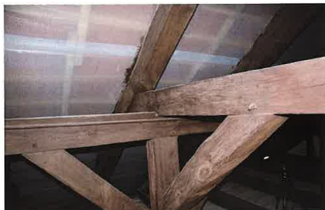
Fot. nr 109 Węzeł ramy stolcowej
