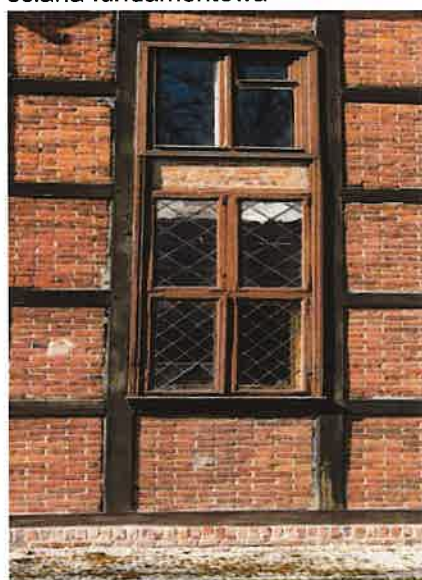
Fot. nr 39 Ściana wschodnia; nowa warstwa cegły cokołowej wykonanej w 2009 roku oraz uzupełnienie ściany wypełniającej po wstawieniu nowego okna
