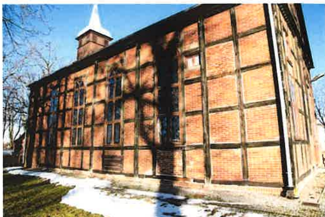
Fot. nr 11 Ściana południowa- widoczna prawie na całej długości oryginalna konstrukcja ryglowa ściany
