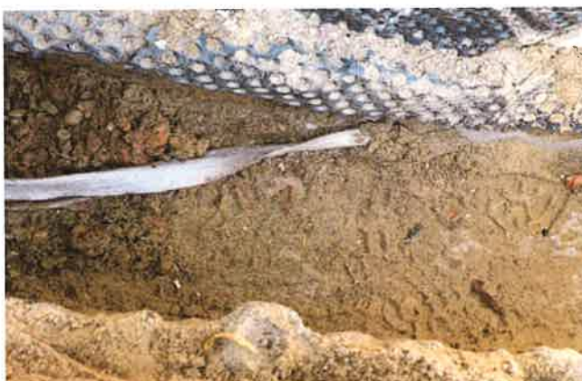
Fot. nr 123 Ściana południowa - odkrywka fundamentów; widoczna folia kubełkowa oraz zasypka drenażu opaskowego
