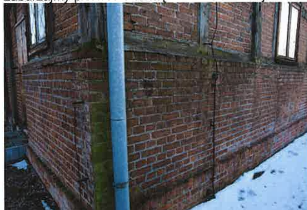
Fot. nr 38 Północno-wschodni narożnik – wysoka ściana fundamentowa
