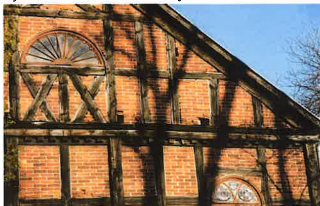
Fot. nr 53 Ściana zachodnia – widok gzymsu okalającego oraz elementów zdeformowanej ryglowej konstrukcji szczytu; widoczne są również podwaliny podkonstrukcji nośnej podtrzymującej wieżę
