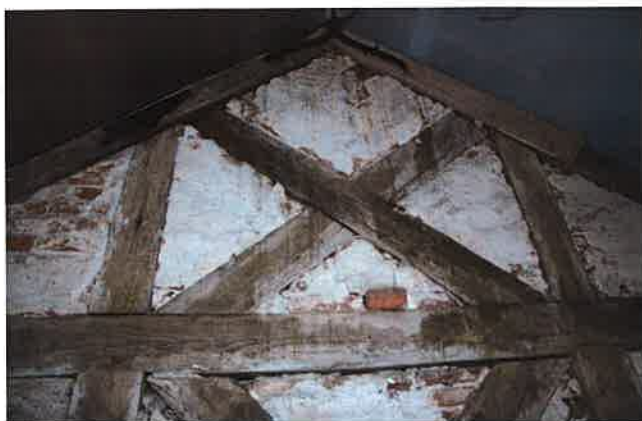
Fot. nr 106 Konstrukcja ryglowa ściany szczytowej wschodniej wraz z wypełnieniem
