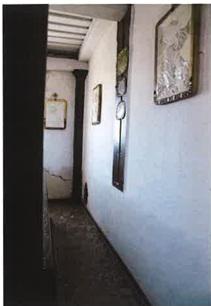
Fot. nr 81 Ściana północna- stan tynków wewnętrznych
