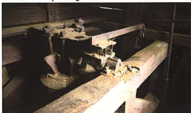
Fot. nr 117 Konstrukcja wieży - układ nośny dla zawieszenia dzwonów
