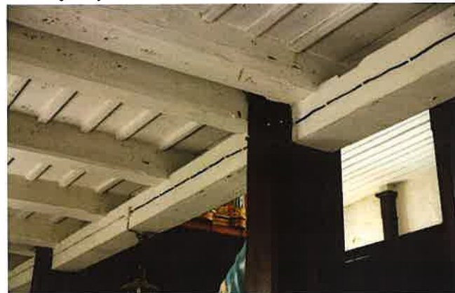
Fot. nr 102 Konstrukcja stropu belkowego empory
