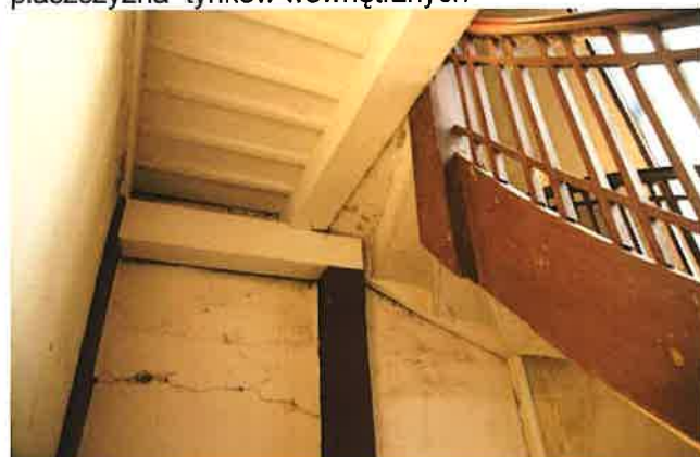
Fot. nr 80 Wewnętrzna drewniana klatka schodowa; widok na ścianę południową
