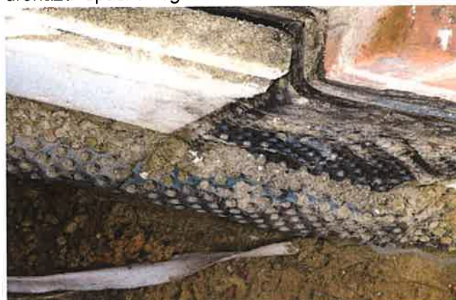
Fot. nr 125 Ściana południowa- odkrywka fundamentów; widoczna folia kubełkowa oraz izolacja termiczna - styropian o gr. 5 cm ułożona w przestrzeniach międzysłupowych
