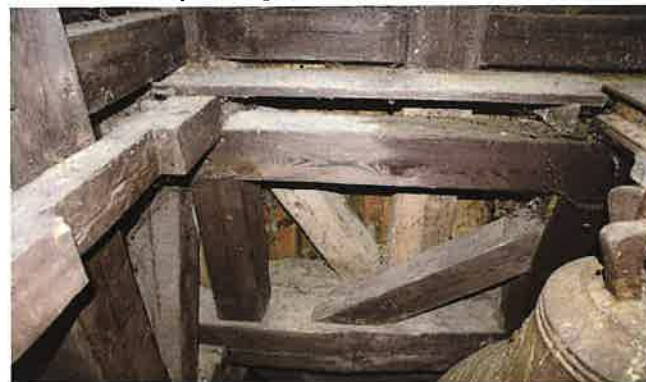
Fot. nr 118 Konstrukcja wieży - układ nośny dla zawieszenia dzwonów
