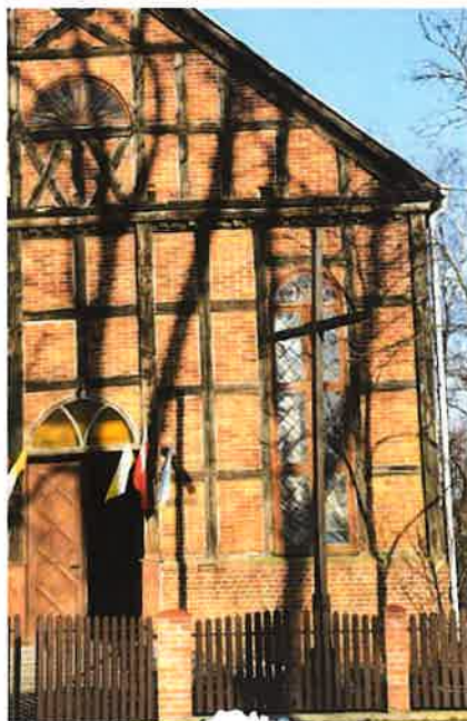
Fot. nr 9 Elewacja frontowa - ściana zachodnia – przymurowana ściana fundamentowa - południowo-zachodni narożnik
