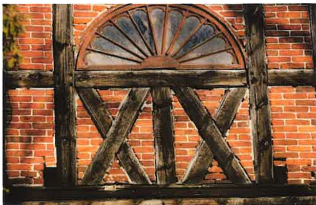
Fot. nr 75 Ściana zachodnia – konstrukcja ryglowa ściany szczytowej
