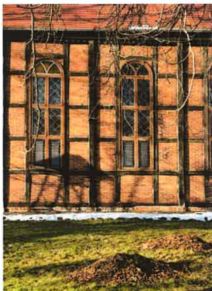
Fot. nr 13 Ściana południowa – pierwotna forma konstrukcji ryglowej wraz ze stolarką okienną
