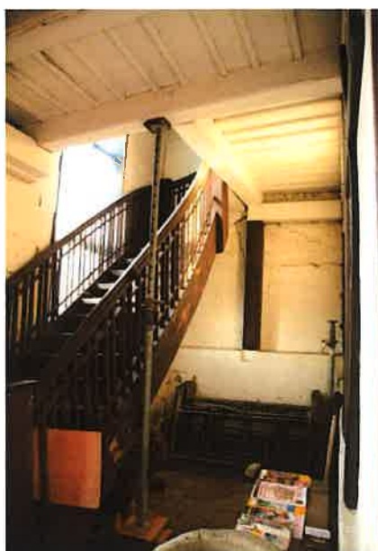
Fot. nr 77 Wewnętrzna drewniana klatka schodowa; widok na ścianę północną i stan tynków wewnętrznych
