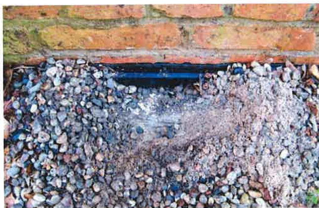
Fot. nr 122 Ściana południowa – opaska wokół kościoła wykonana z warstwy płukanego żwiru wykonana w 2009 roku; widoczna listwa mocująca folię kubełkową
