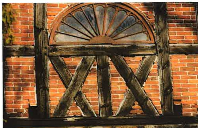
Fot. nr 142 Ściana zachodnia, szczytowa – pierwotna forma konstrukcji ryglowej wraz z półrozetą okienną
