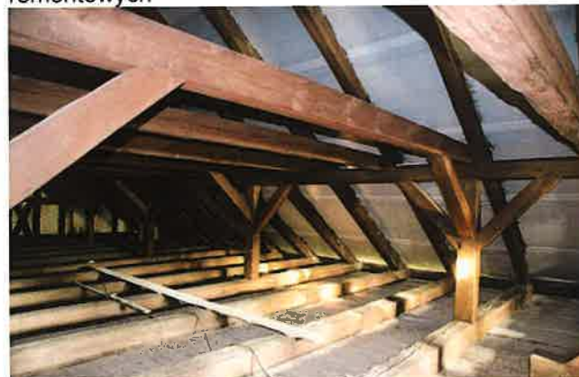
Fot. nr 110 Widok więźby dachowej
