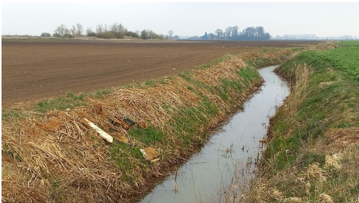
Fot. 3. Główny kanał zbiorczy odprowadzający wody powierzchniowe w granicach przedmiotowego obszaru w kierunku północnym
