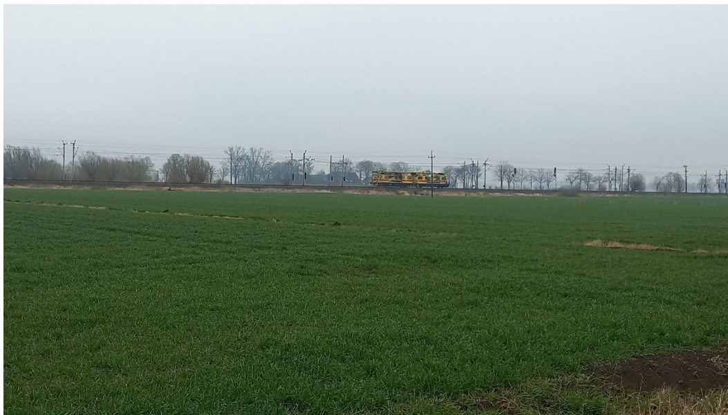
Fot. 7. Nasyp kolejowy linii nr 9 widoczny z północnych krańców obszaru objętego projektem planu
